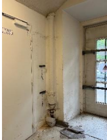
Photos 1 et 2. Exemples des descentes EP exposées dans les bureaux côté ville Photo 3. Exemple de trappe de visite dans la galerie de circulation au centre de l'aile Photo 4. Exemple de trappe de visite dans l'espace d'exposition côté Seine
