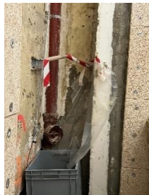
Photo 1. Exemple de descente EP exposée dans les espaces techniques au centre de l'aile
