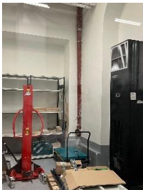
Photo 1. Exemple de descente EP exposée dans les espaces techniques au centre de l'aile
